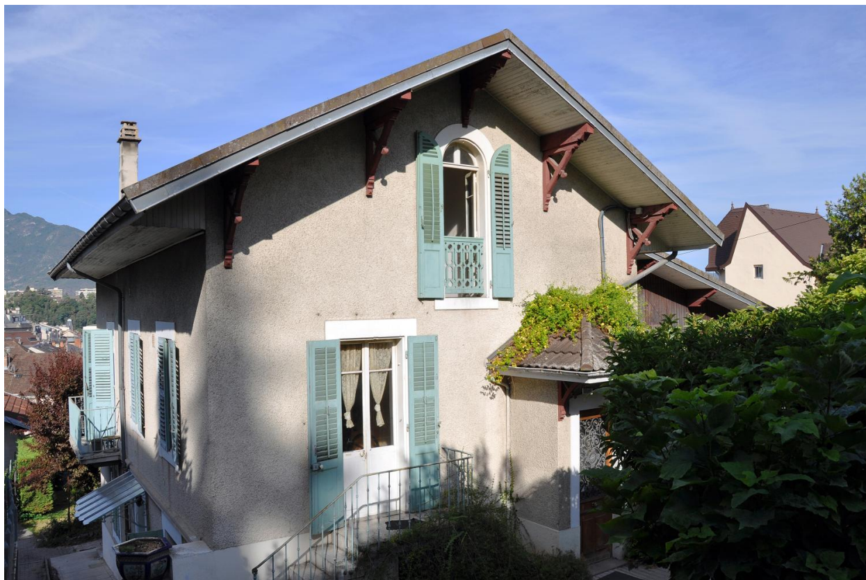
Pignon de la façade est
