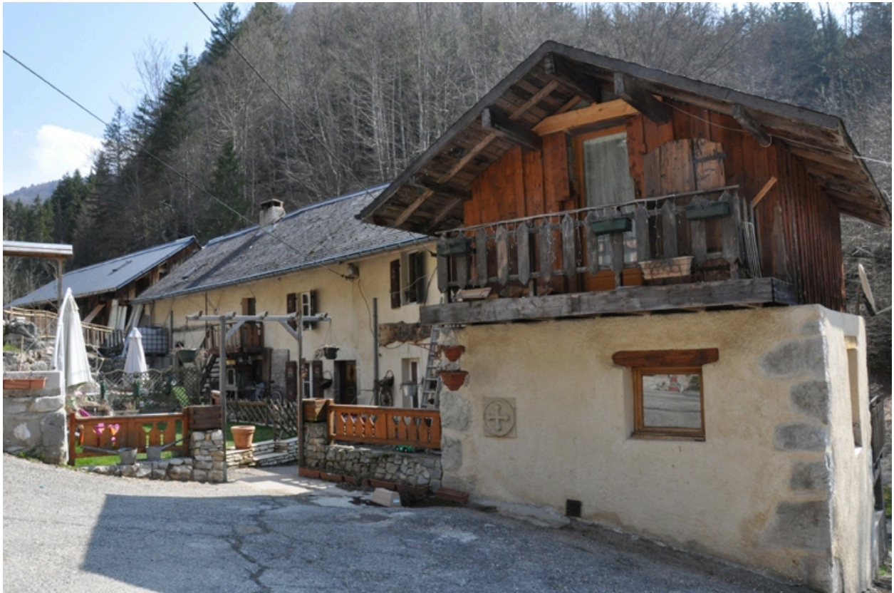
Vue du moulin, façade ouest
