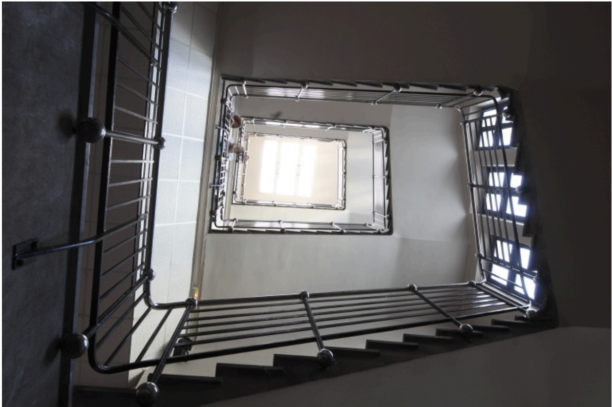
Escalier principal du lycée, vu depuis le rez-de-chaussée.
