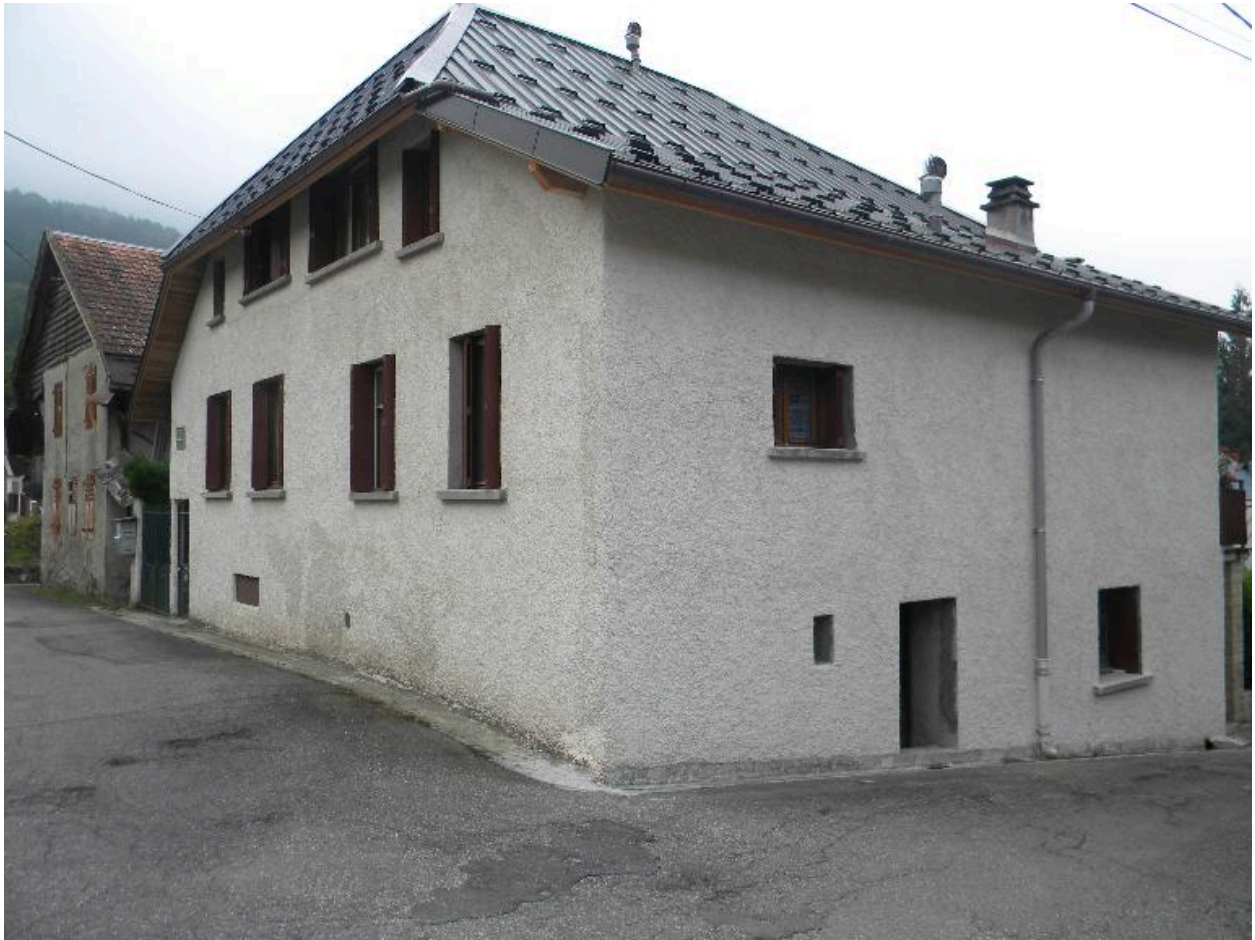
Vue d'une ancienne ferme entièrement crépie au ciment (2008 E10 1468, 2344).
