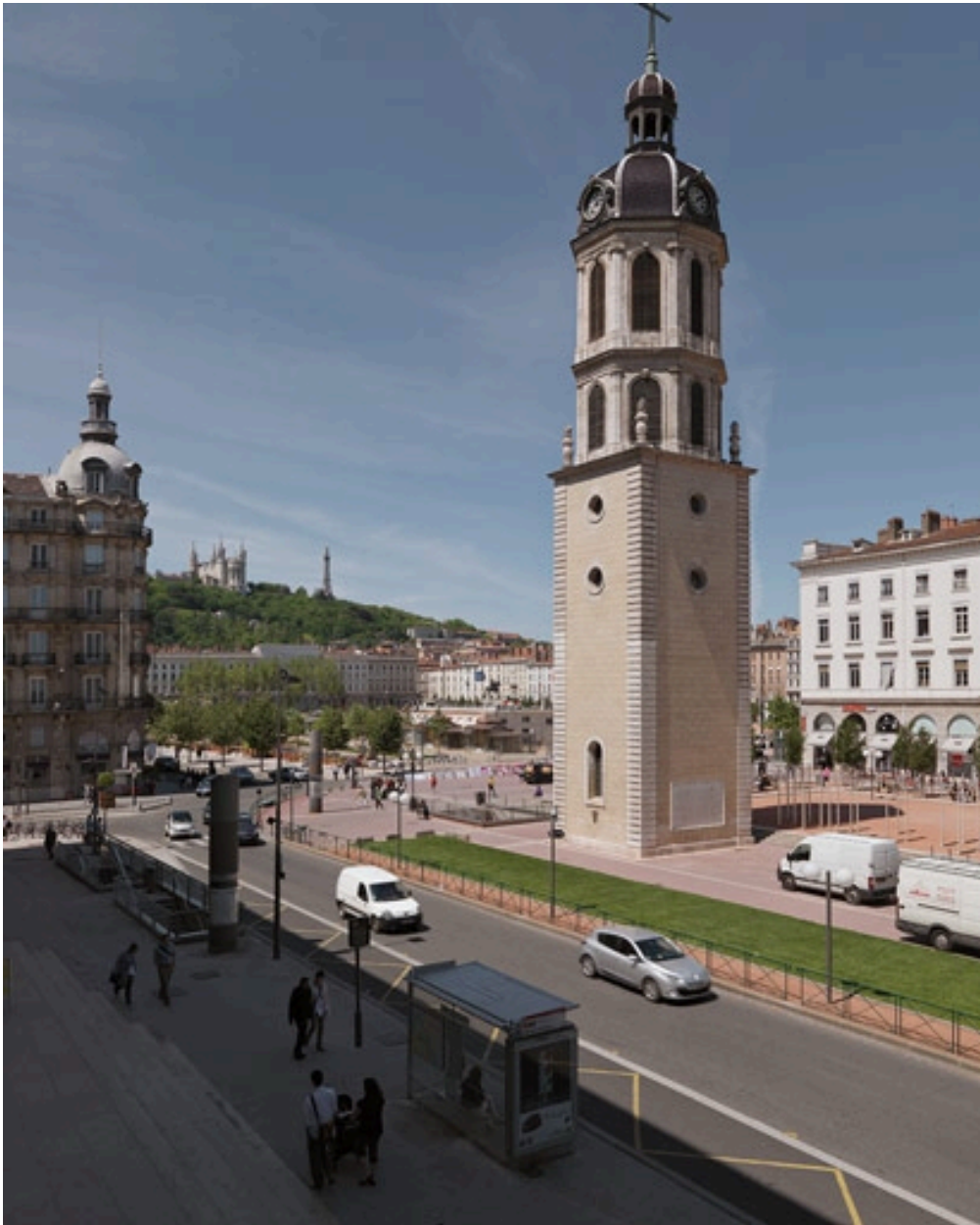
Clocher : vue générale prise de l'hôtel des Postes, depuis le sud-est
