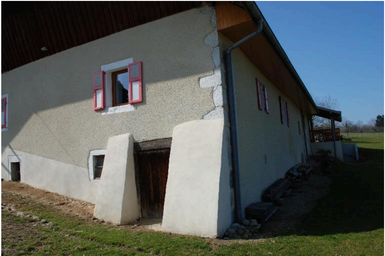
Détail de l'angle inférieur droit du mur pignon est.
