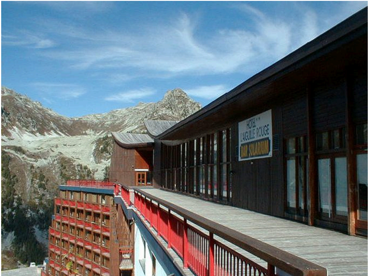
Terrasse supérieure le long de la façade sud
