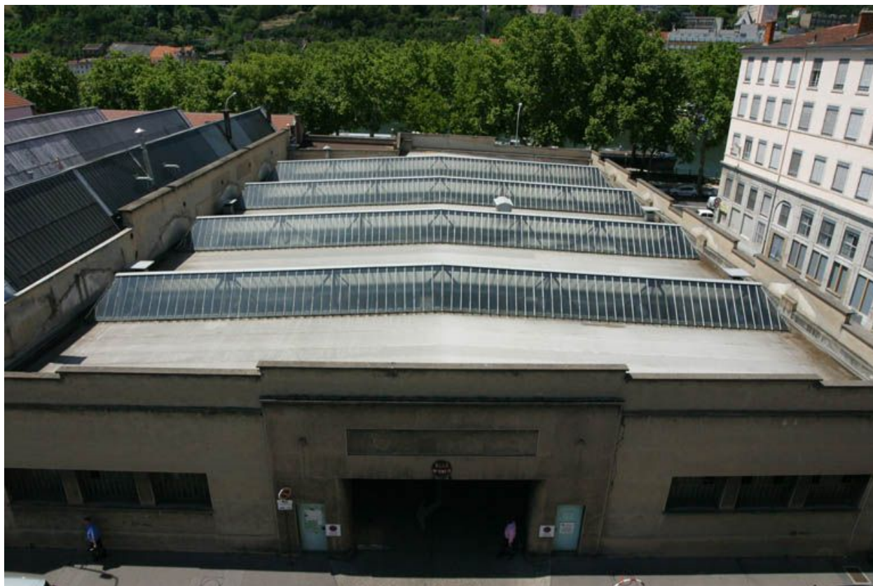
Toit du petit dépôt, vue est
