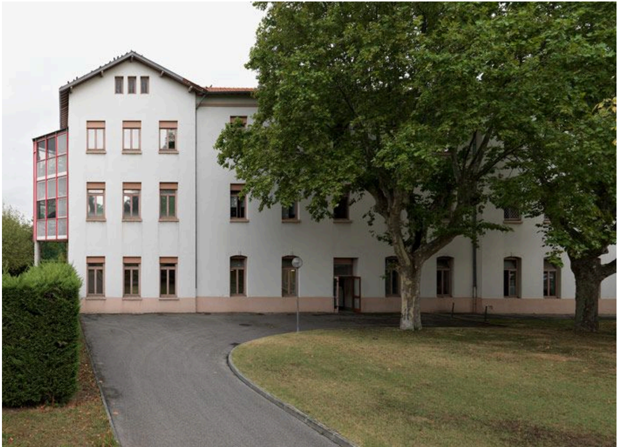
Bâtiment ouest, façade principale (est)
