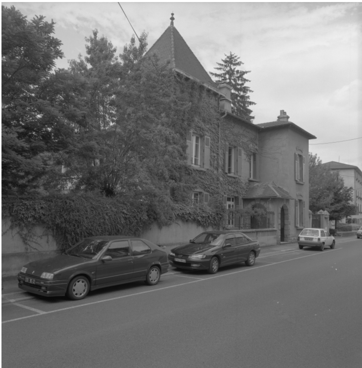
Boën, îlot 21, 8 Mai 1945 (rue du) 8. Vue générale de la façade sur rue, depuis l'est.
