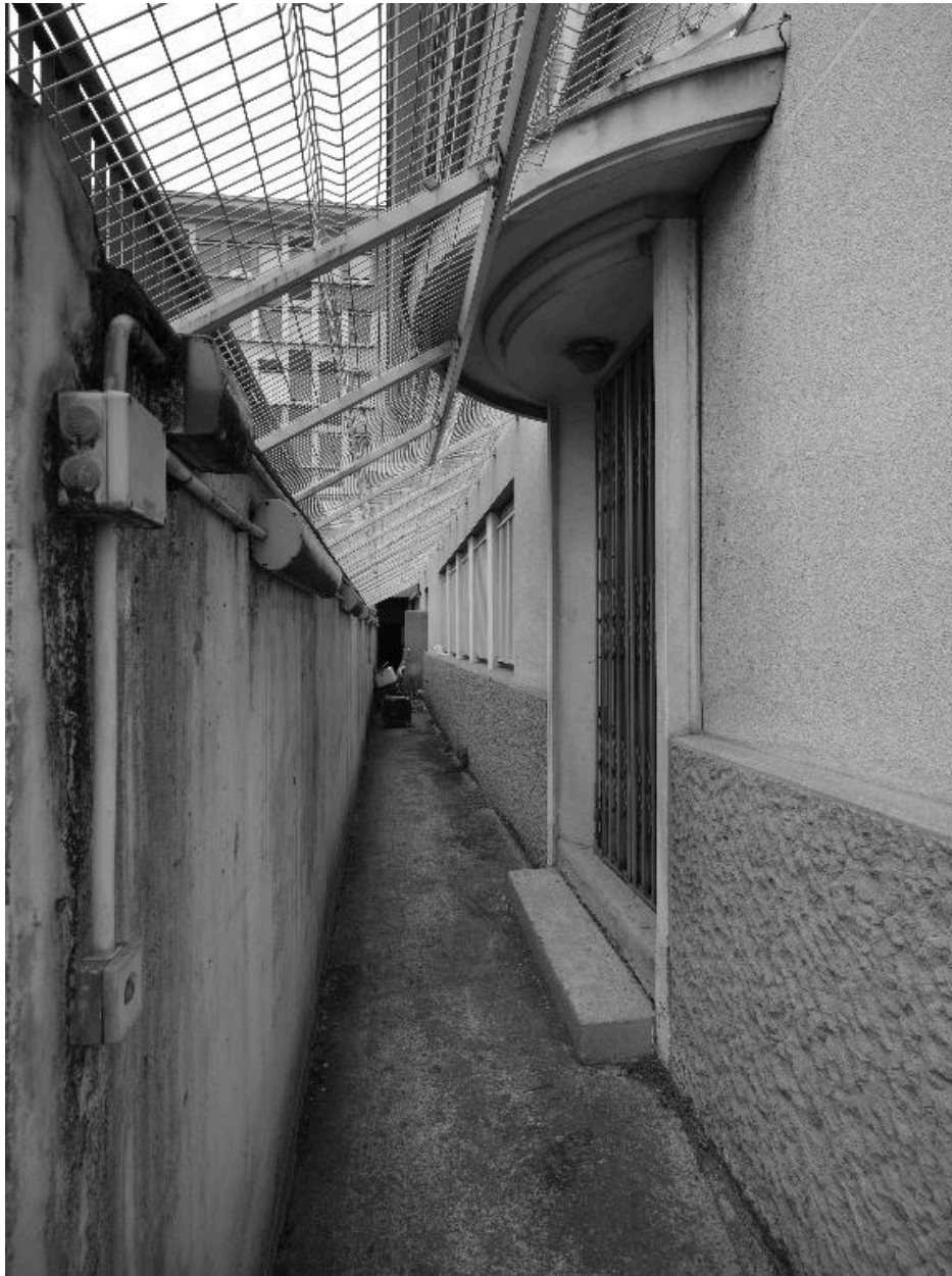
Bâtiment rue Duhamel : ancienne entrée au rez-de-chaussée sur cour et cour anglaise
