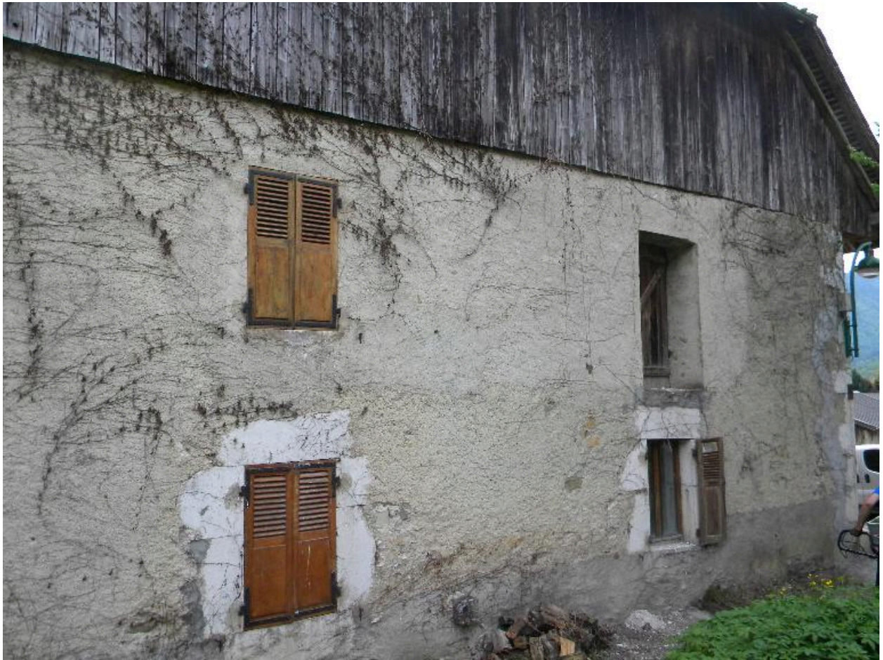
Vue du pignon ouest d'une ancienne ferme mitoyenne (2008 A5 870, 871)
