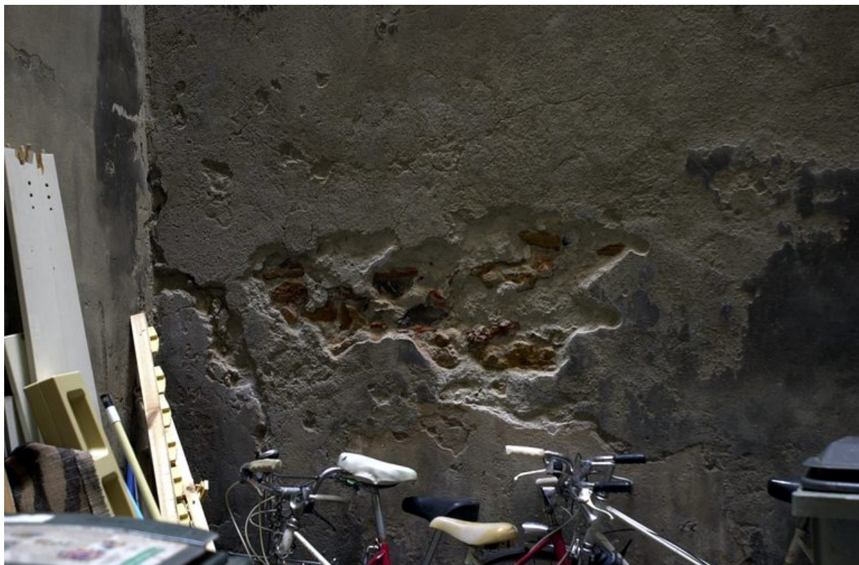
Mur sud de la cour : détail de matériaux
