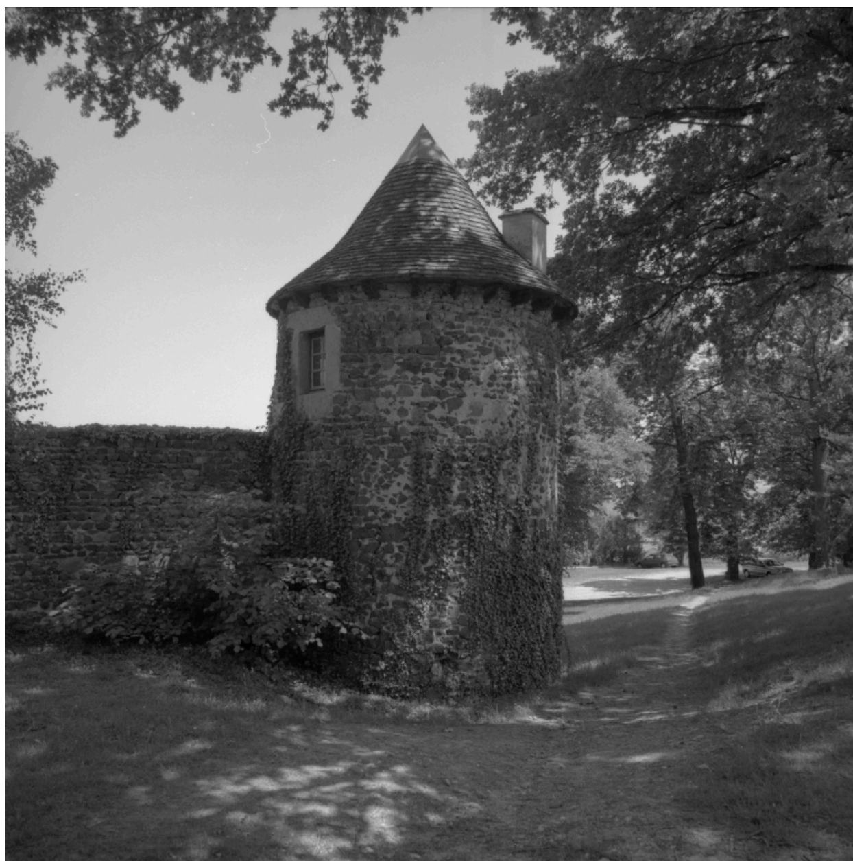
Vue de la tour d'enceinte ouest, de l'ouest.
