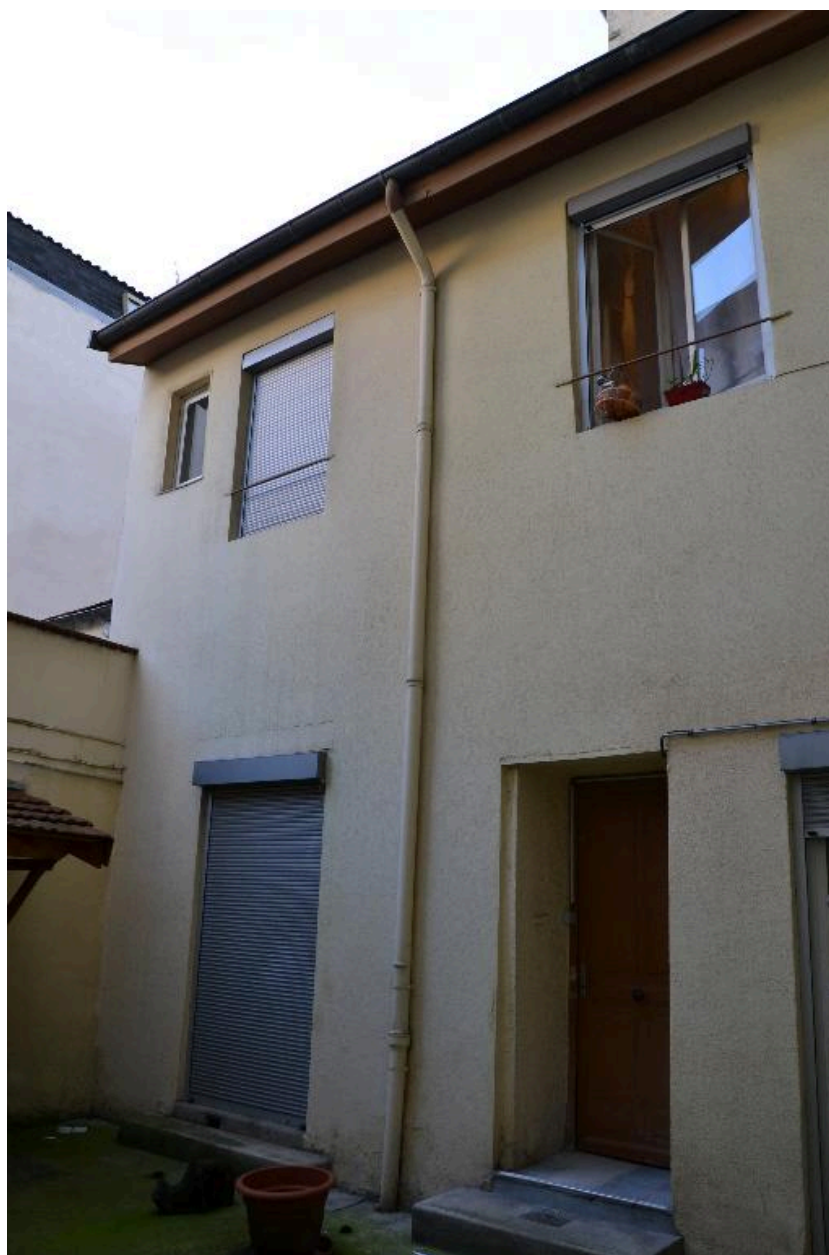
Façade second corps de bâtiment
