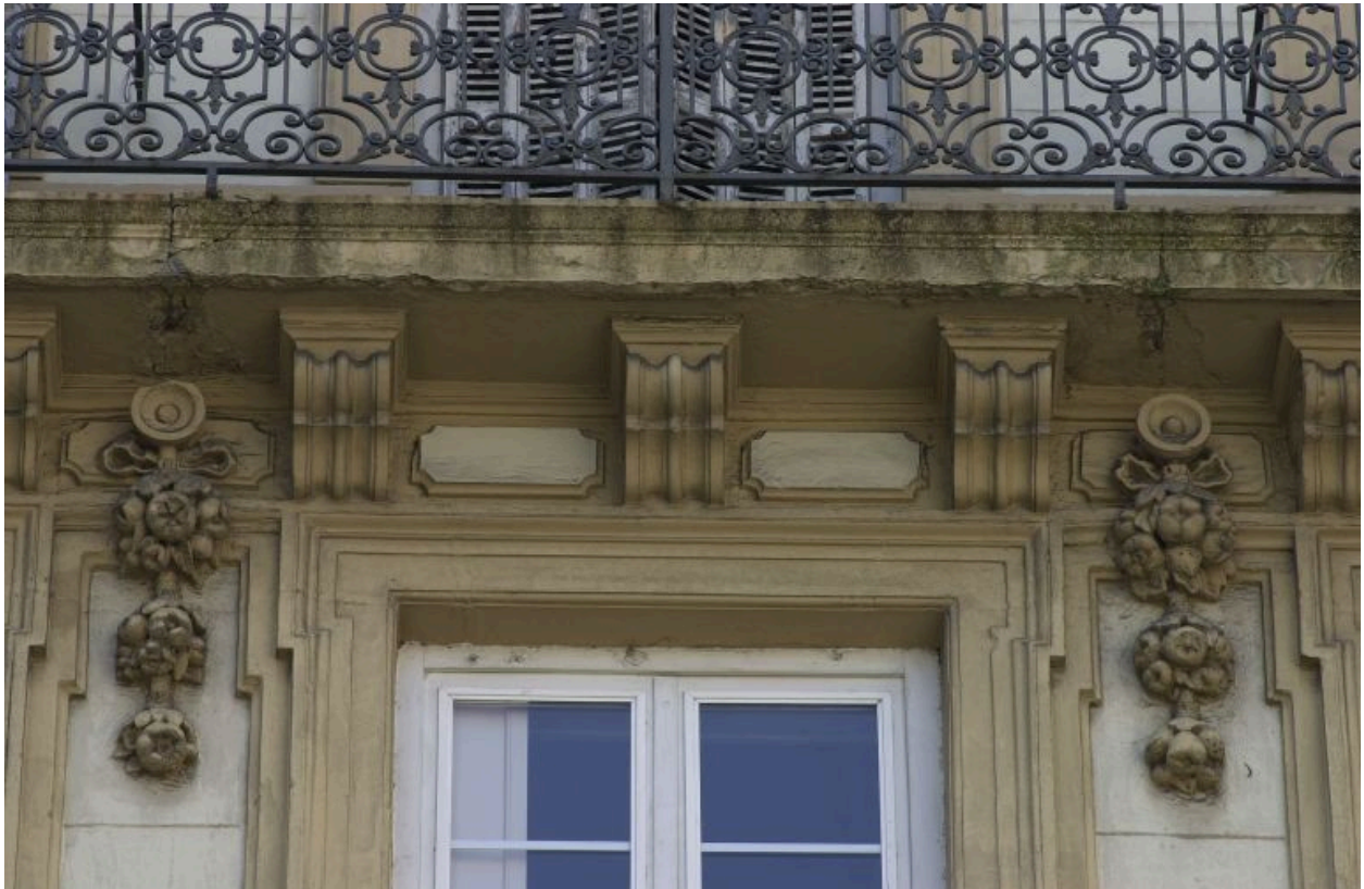
Façade principale, 5e niveau, détail de la 6e fenêtre
