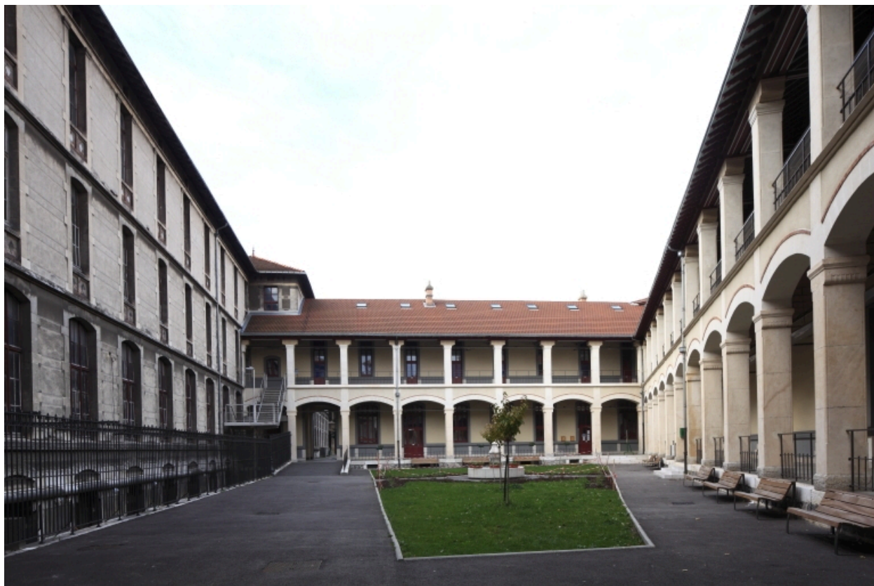
Cour I. Vue d'ensemble.
