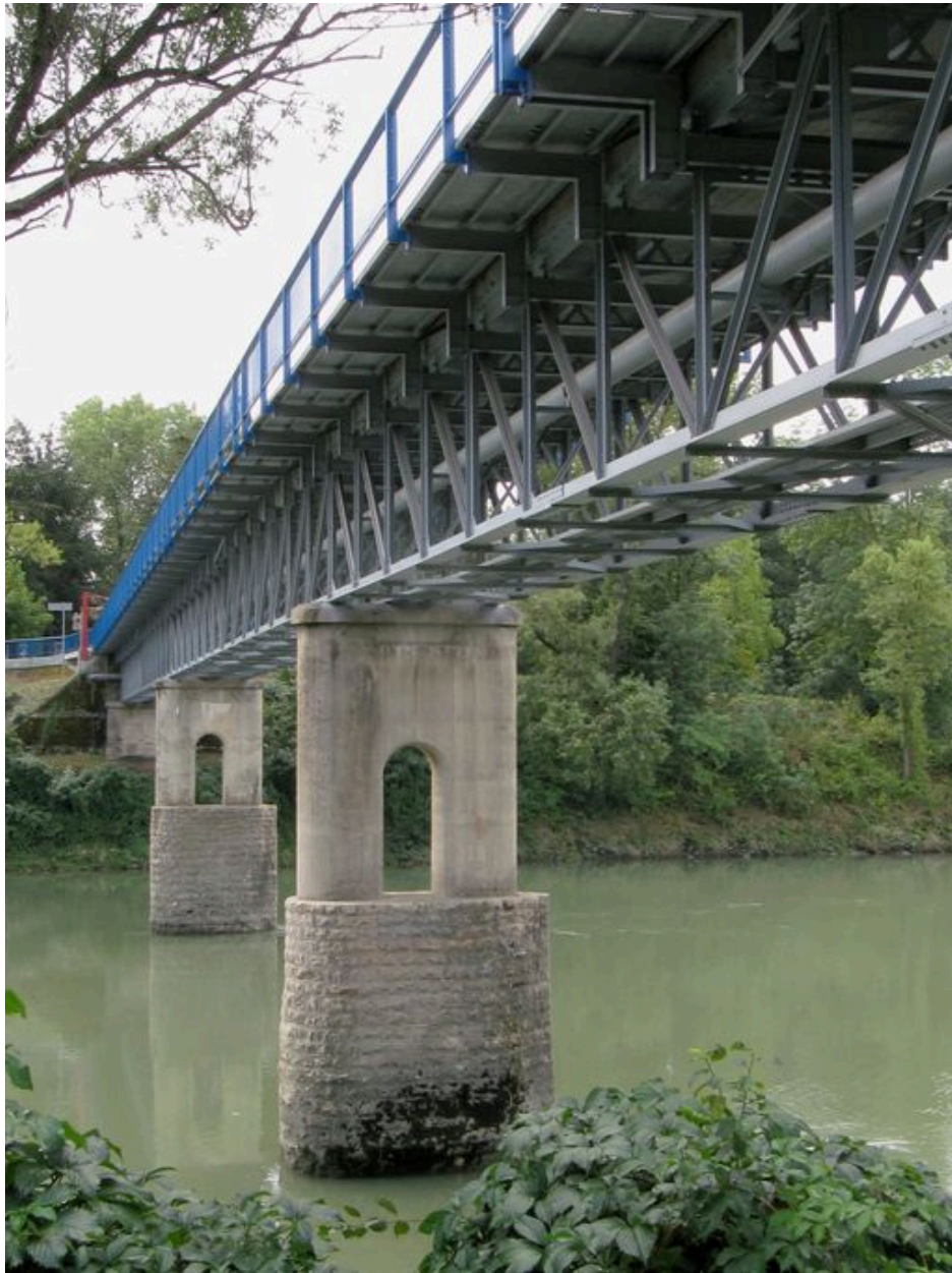
Piles et tablier, face amont (depuis la rive droite)
