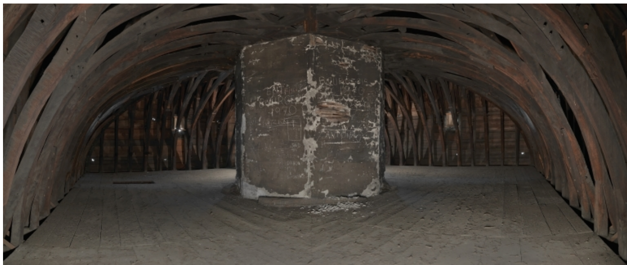
Le dôme des Quatre Rangs. 2e niveau de charpente. Vue d'ensemble
