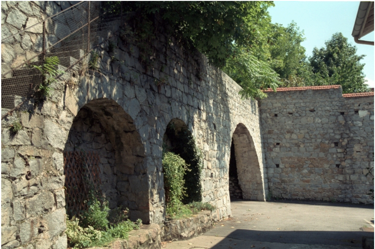
Boën, îlot 22, Lyon (rue de) 27. Détail de l'escalier su cour.
