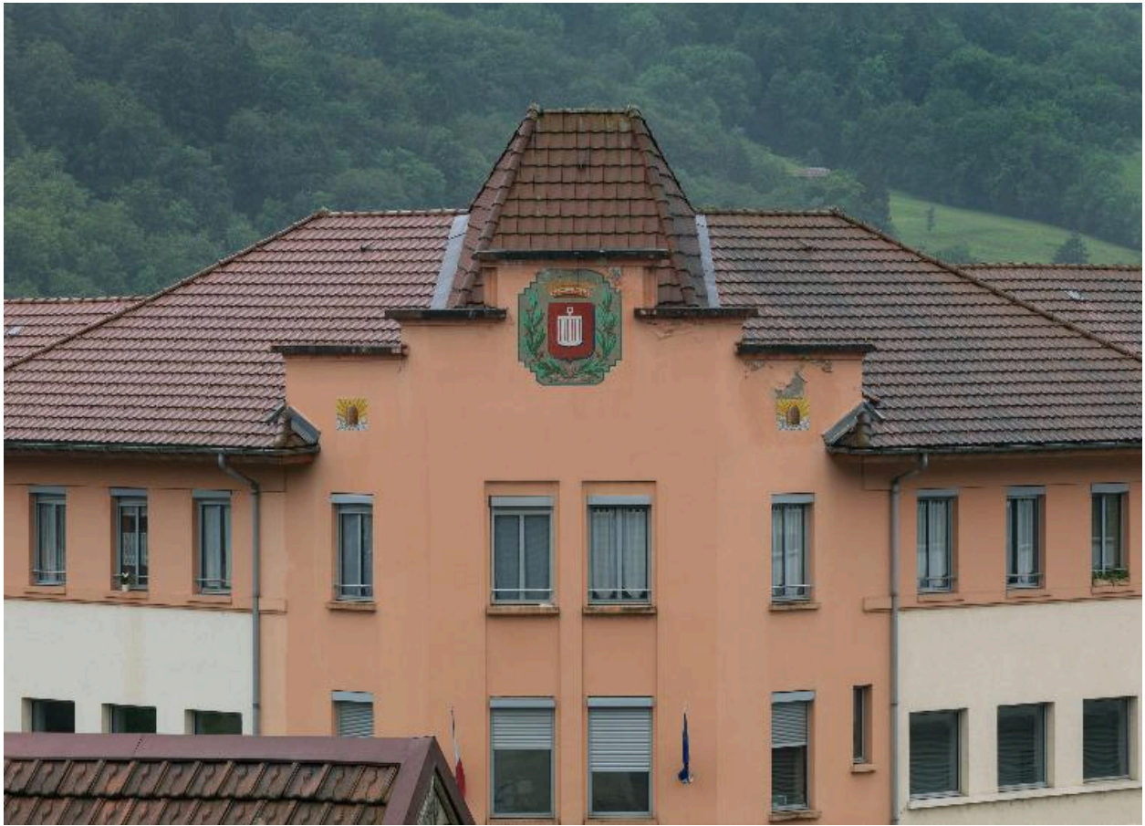
Elévation principale, vue partielle
