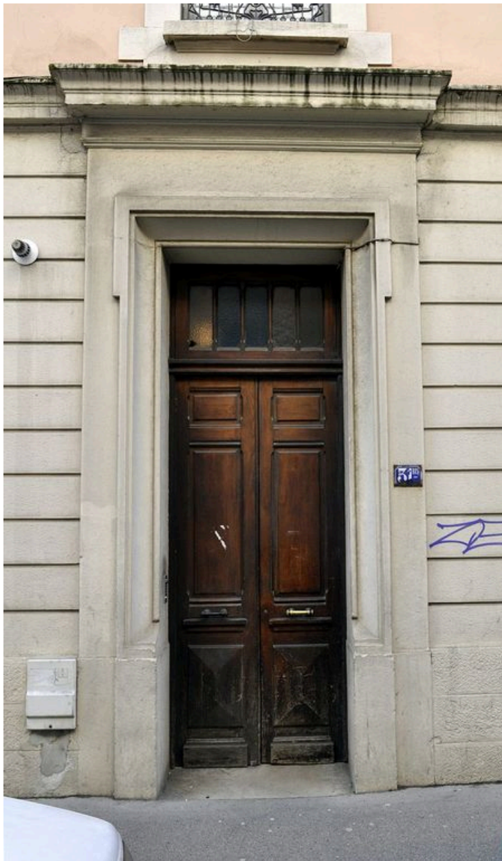
Façade antérieure, détail : porte d'entrée du 31 bis
