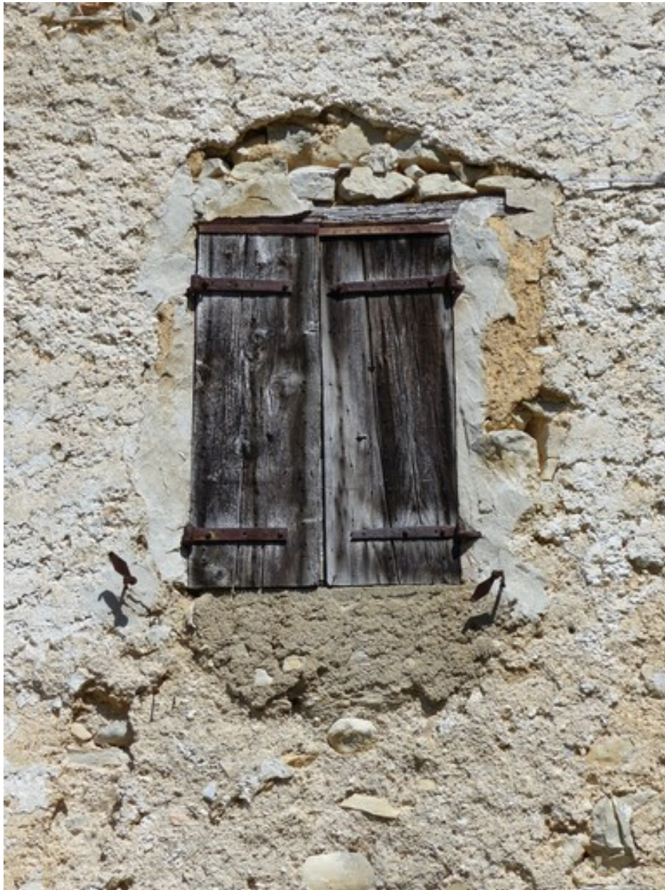
Pignon ouest, deuxième niveau. Fenêtre occultée par des contrevents en planche.
