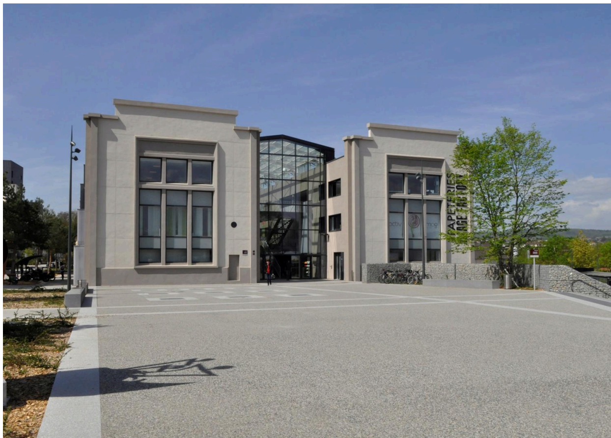
Papeteries de Cran-Gevrier, vue extérieure
