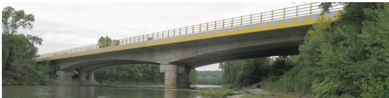
Vue panoramique, face amont (depuis la rive droite)
