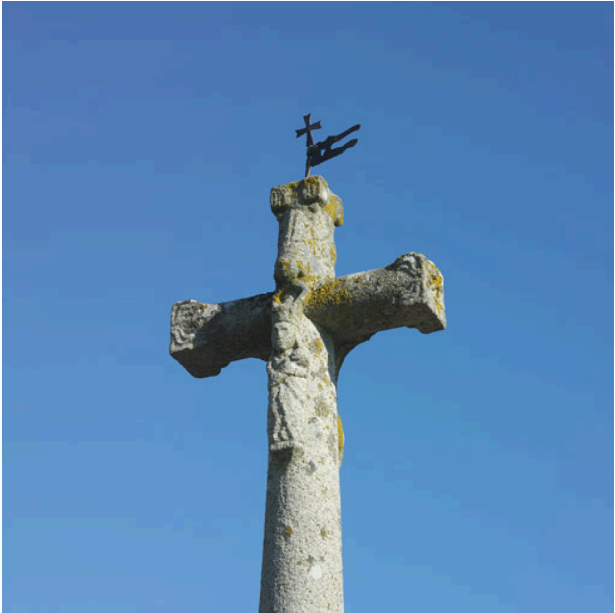
Détail du croisillon, de trois-quarts, côté couronnement de la Vierge.
