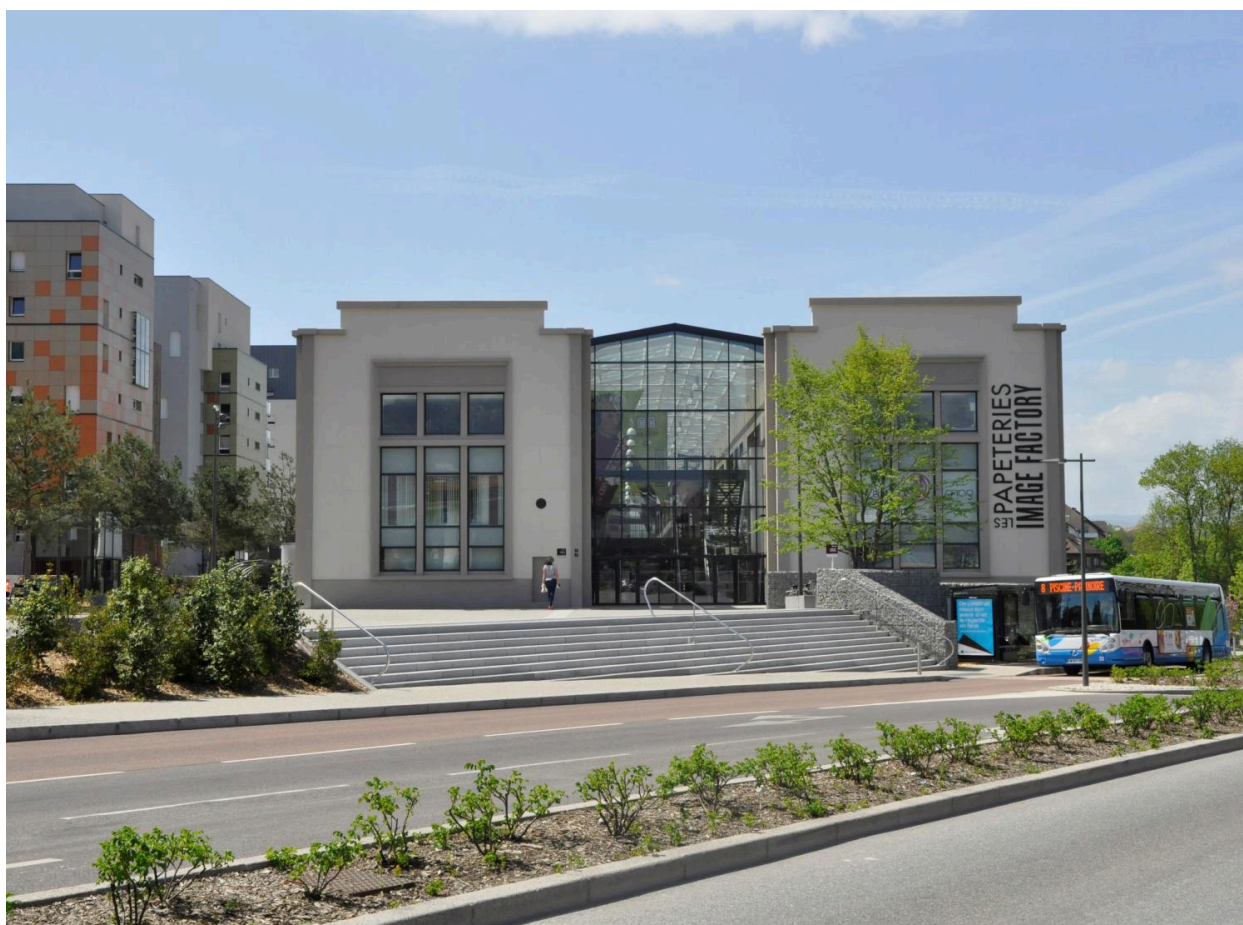
Papeteries de Cran-Gevrier, vue extérieure
