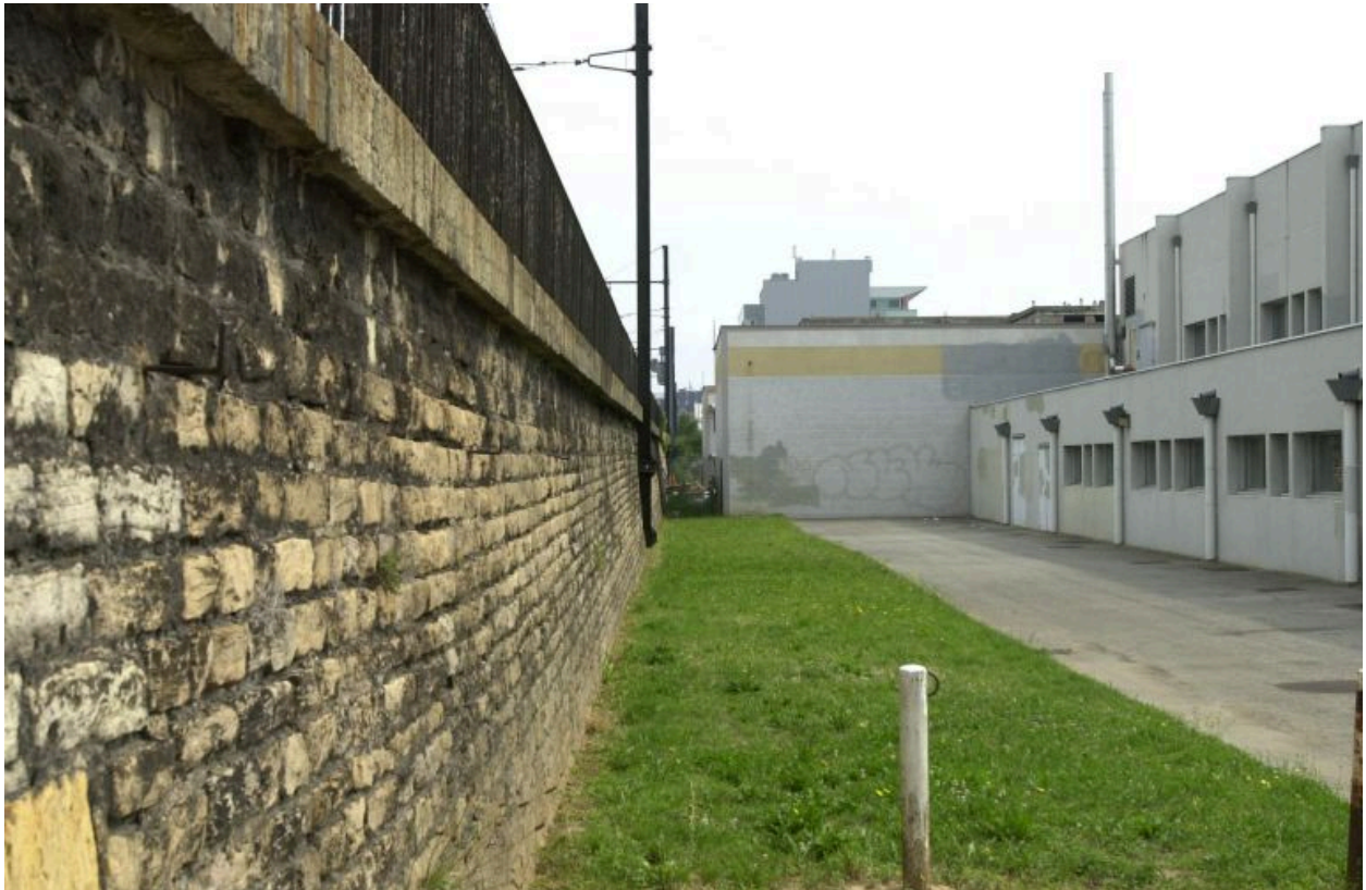
Vue du passage à l'est de la voie ferrée depuis la rue Casimir-Perier vers le nord
