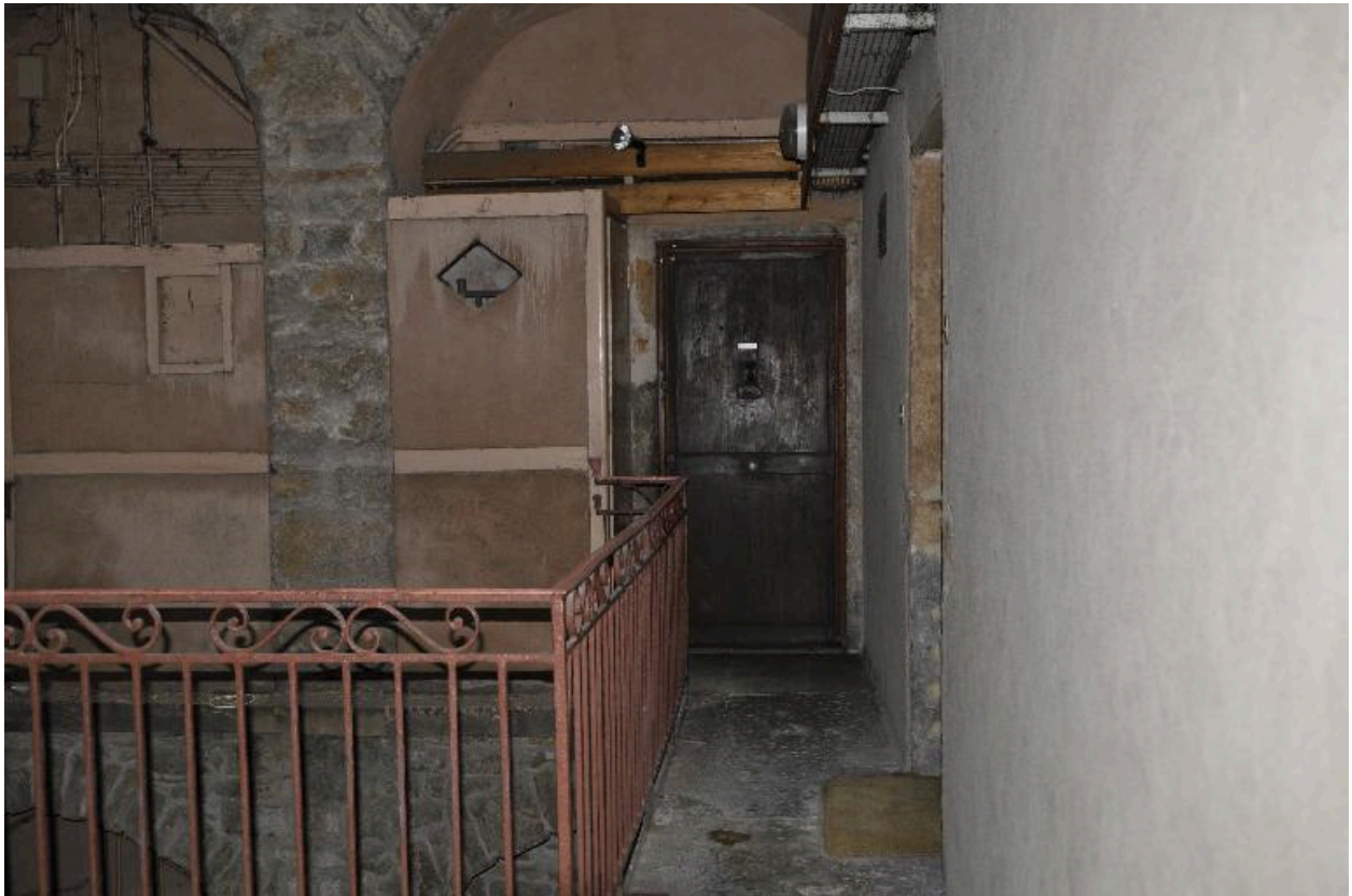
Latrines et porte d'un appartement au premier étage du n°12 rue Dumenge
