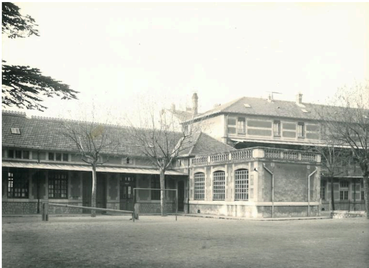
La cour et le bâtiment sud, 1955
