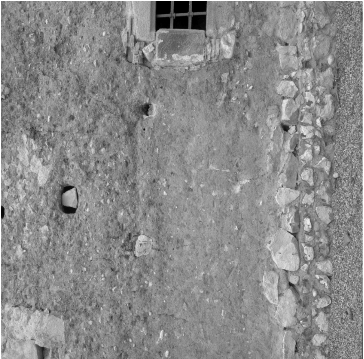
Façade sur jardin du corps de galerie après décroûtage : détail de la mise en oeuvre en pisé du corps primitif.
