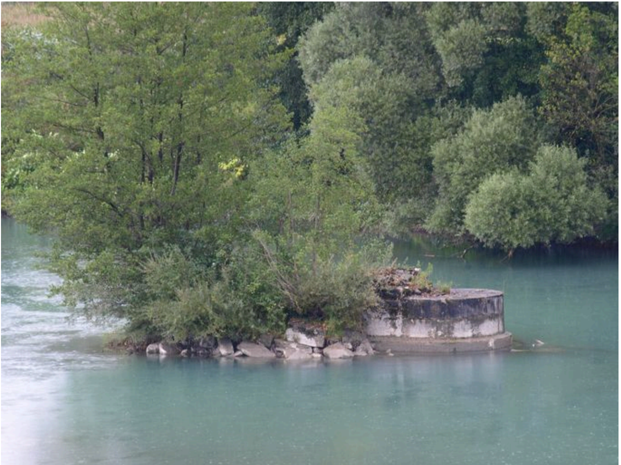
Vestige d'une autre pile, en aval du pont routier (depuis la rive gauche)
