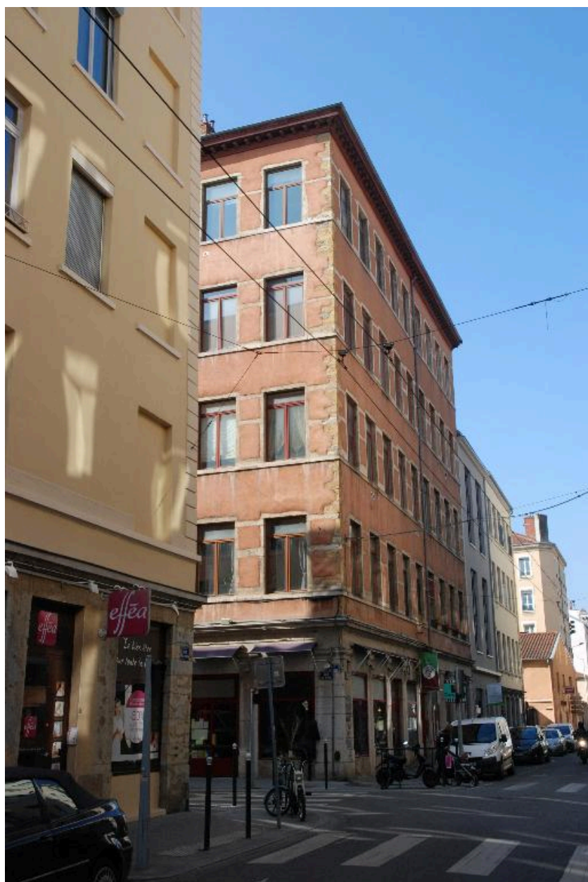
Vue d'ensemble nord est
