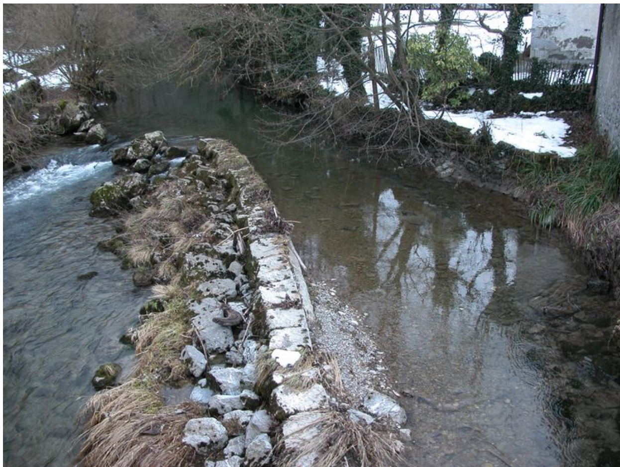
Vue du canal d'amenée d'eau de la scierie.
