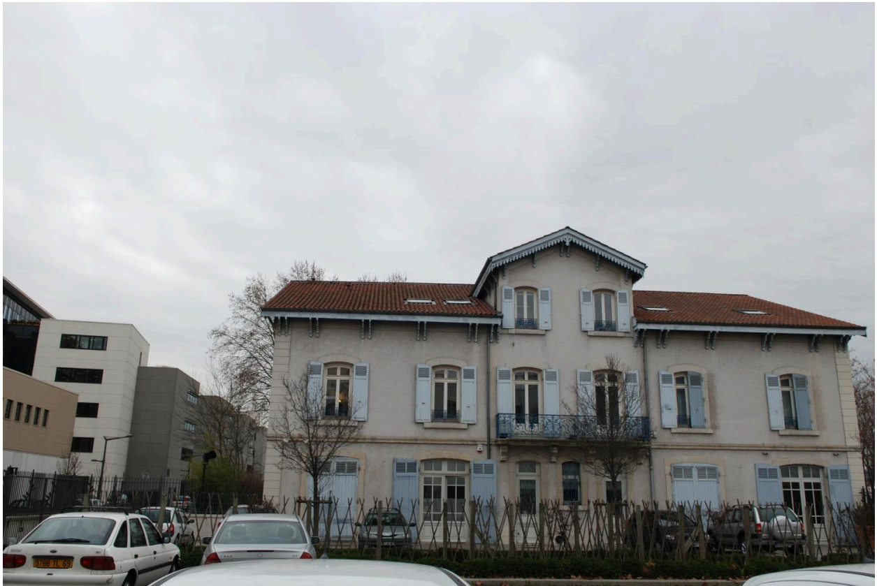
Détail façade sud
