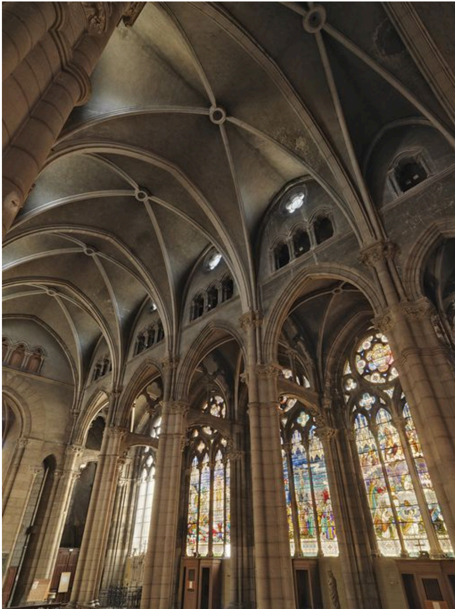
Détail du voûtement et du triforium.
