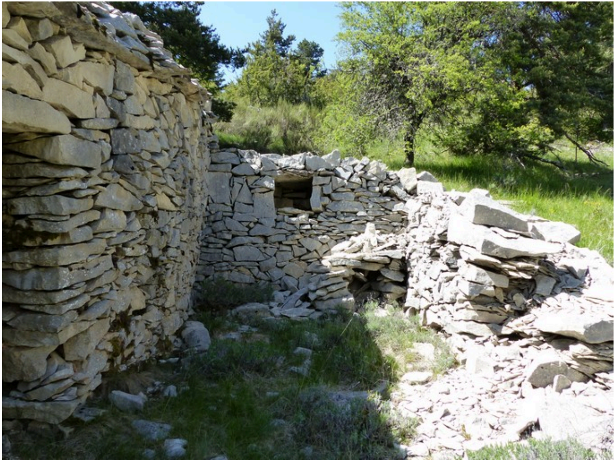
Enclos. Vue d'ensemble prise de l'est.
