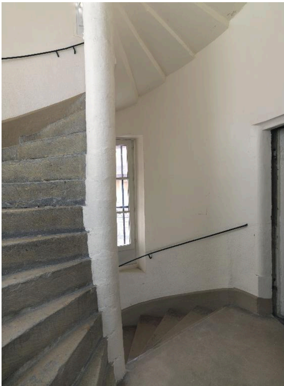
Vue de l'escalier en vis, situé dans la tourelle polygonale.
