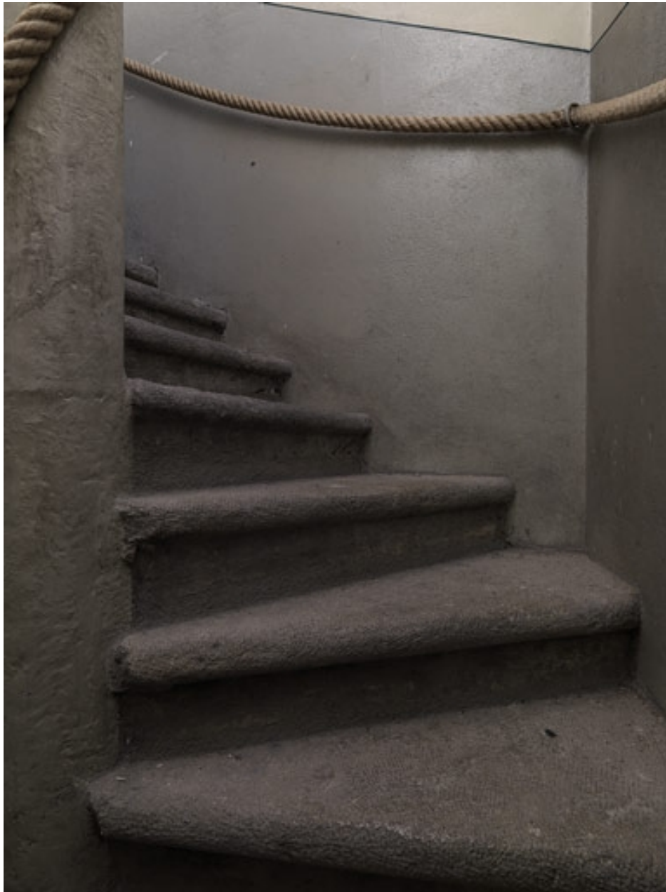
Bâtiment S nord. Escalier dit de la Corde. Les marches
