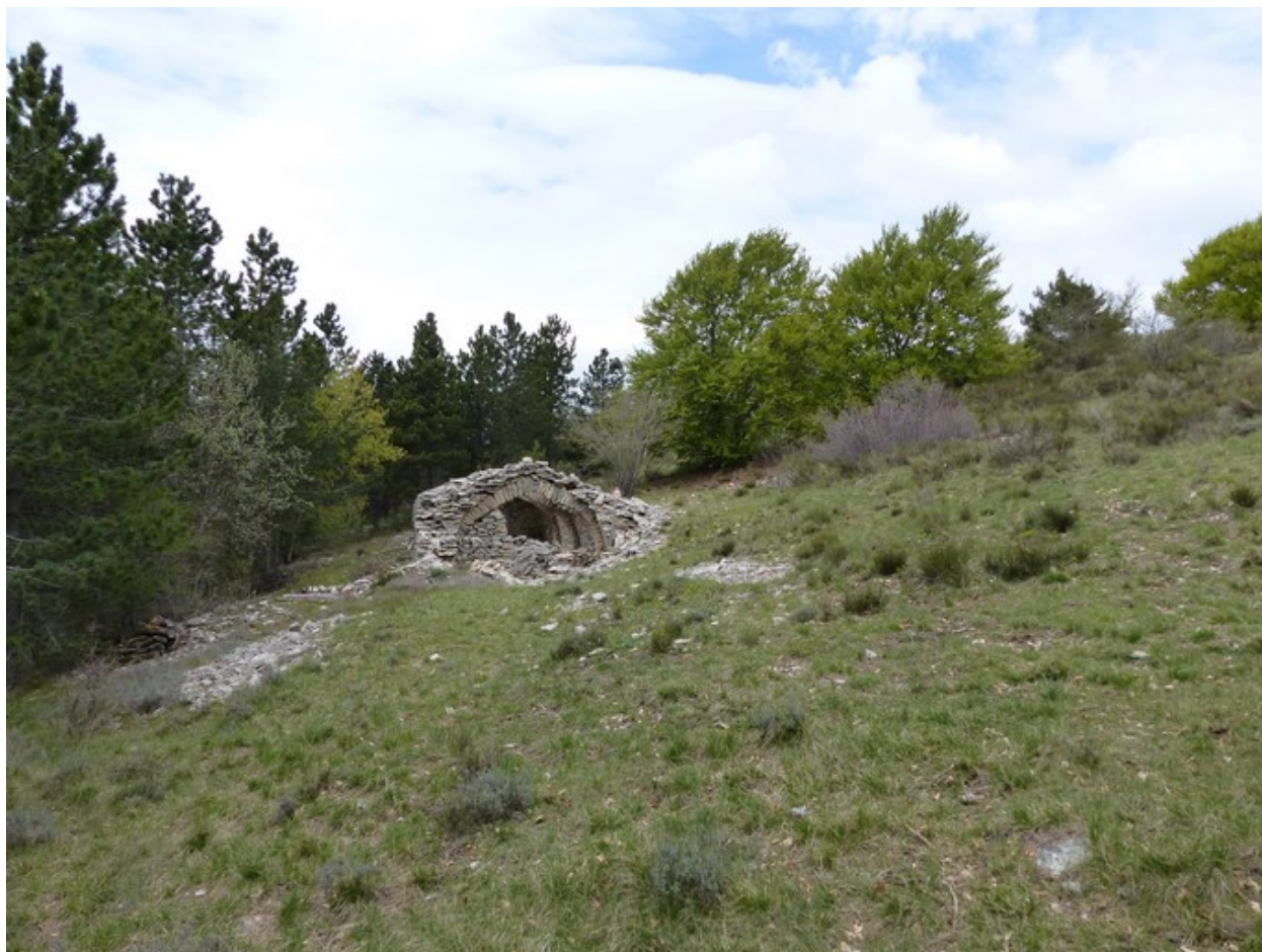
Vue de situation prise du sud.
