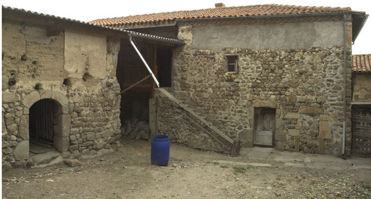
Vue arrière du logis, depuis la seconde cour.
