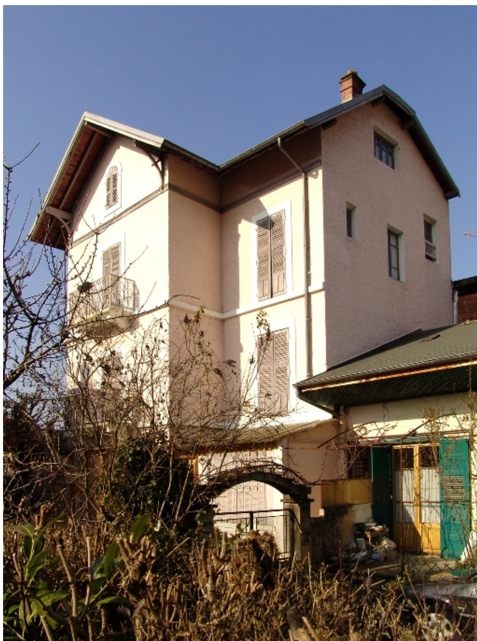
Façades postérieure et latérale gauche
