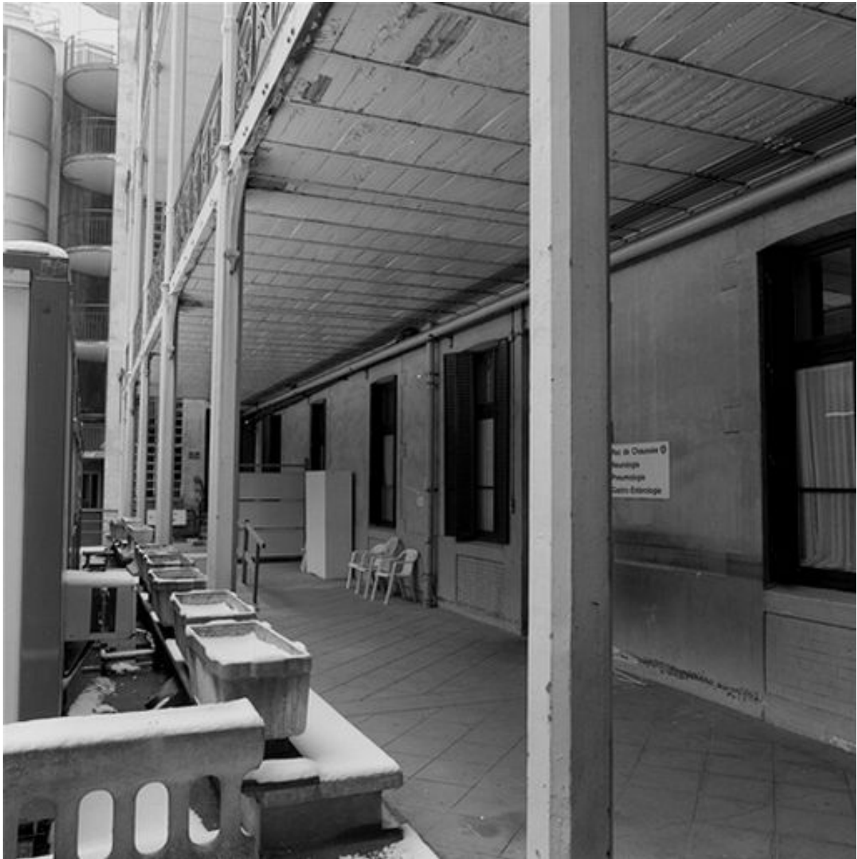
Bâtiment principal, aile sud, rez-de-chaussée de la galerie
