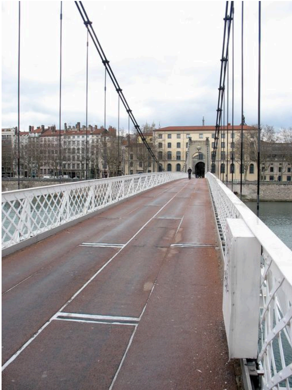
Sur le tablier, vue de la chaussée (vers le collège, côté ouest)
