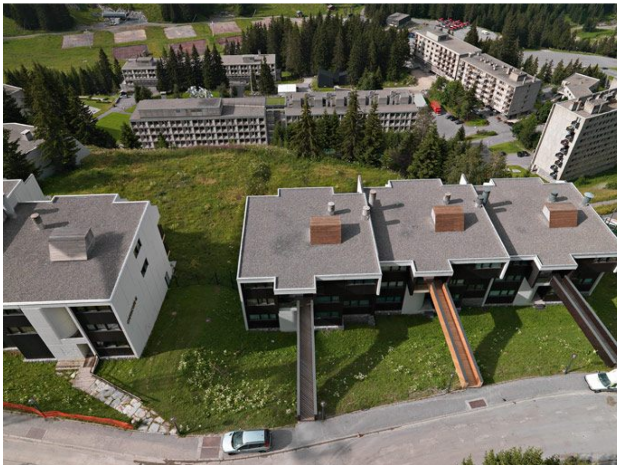
Vue d'ensemble des toitures
