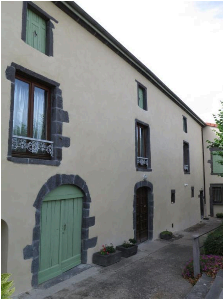
Façade principale sur cour.
