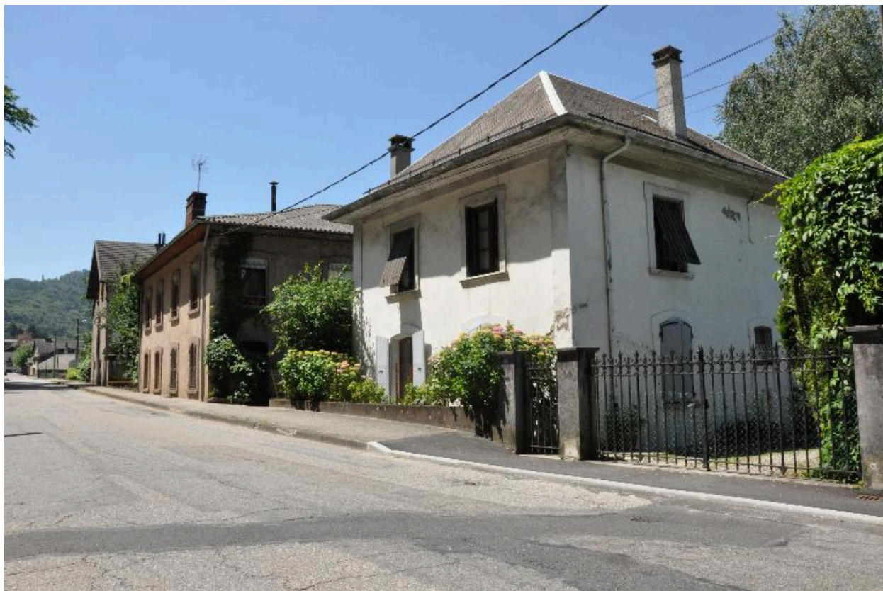
Vue de bâtiments de l'ancienne usine.
