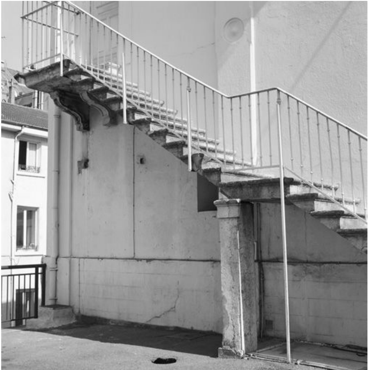
Les bâtiments d'exploitation situés au nord-est. Vue de l'escalier contre le mur pignon
