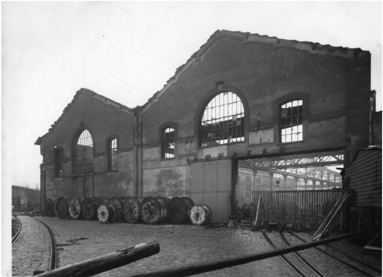
Bombardement de 1944, image d'archive de la société des Câbles de Lyon Nexans
