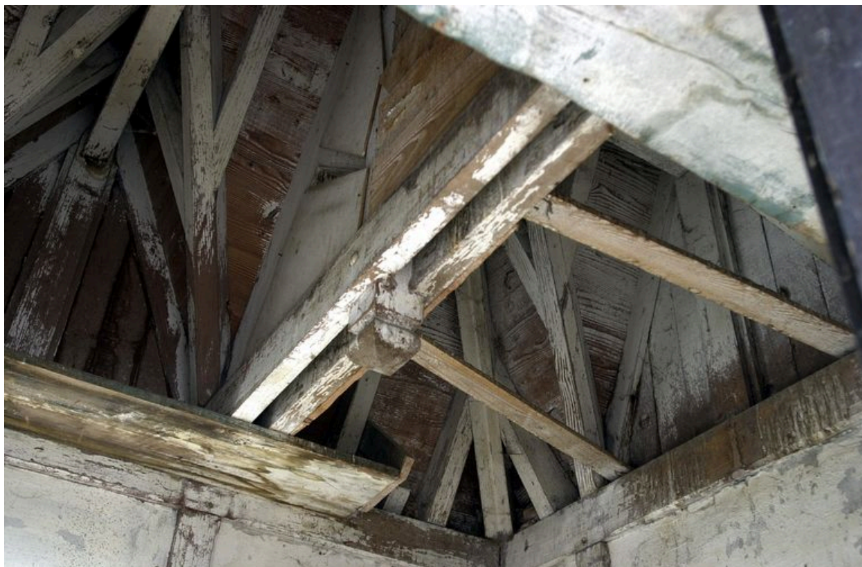
La maison des grues : la charpente
